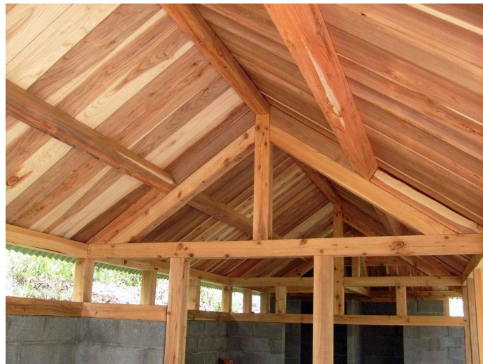
Ceiling frame, La Réunion (France)
